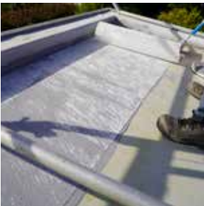
8. 1/2 -2/3 der vorgegebenen Menge Abdichtung in gleichmäßigen Schichtdicken aufbringen.
