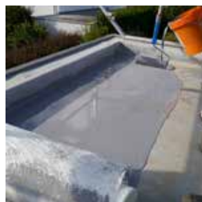
8. 1/2 -2/3 der vorgegebenen Menge Abdichtung in gleichmäßigen Schichtdicken aufbringen.
