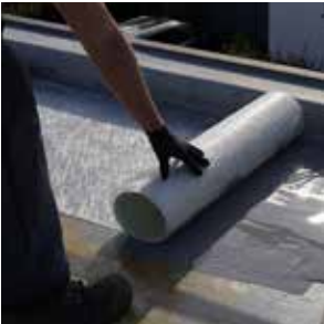
8. 1/2 -2/3 der vorgegebenen Menge Abdichtung in gleichmäßigen Schichtdicken aufbringen.
