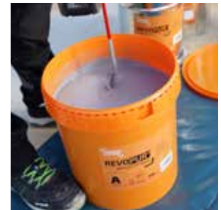
6. gründlich mit dem Korbrührwerk aufrühren.
