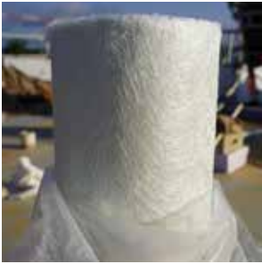
3. REVOPUR FP Vlies- Rolle auspacken, auslegen und ausrichten.
