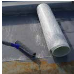
8. 1/2 -2/3 der vorgegebenen Menge Abdichtung in gleichmäßigen Schichtdicken aufbringen.
