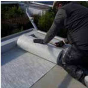
4. REVOPUR FP Vlies- Rolle zuschneiden.
