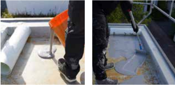
7. Abdichtung auf der Fläche verteilen.
