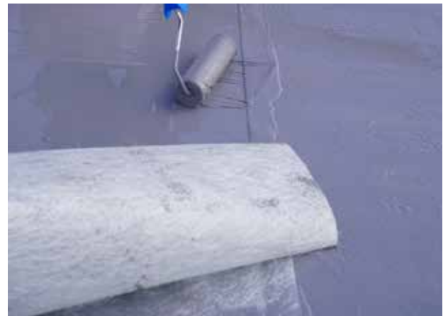
9. In die noch frische Abdichtung der 1. Lage wird das Vlies falten und hohlraumfrei eingebracht und mit einer trockenen Nylonfellrolle angerollt. Die Vlieszuschnitte müssen mindestens 5 cm untereinander überlappen.
