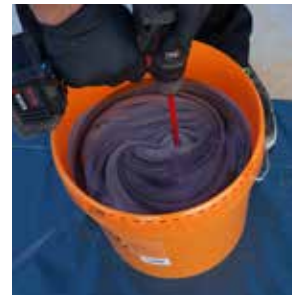
6. gründlich mit dem Korbrührwerk aufrühren.
