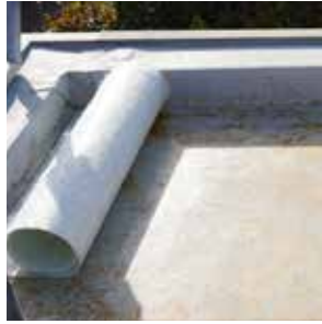
3. REVOPUR FP Vlies- Rolle auspacken, auslegen und ausrichten.
