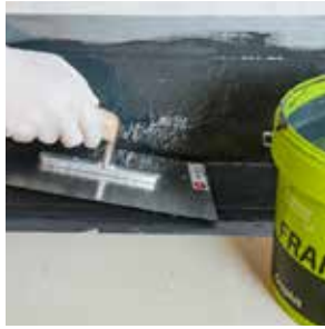
Auftrag der 2. Lage entweder mit Pinsel... oder mit Aufstreichkelle
