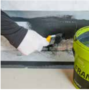
Auftrag der 2. Lage entweder mit Pinsel... oder mit Aufstreichkelle
